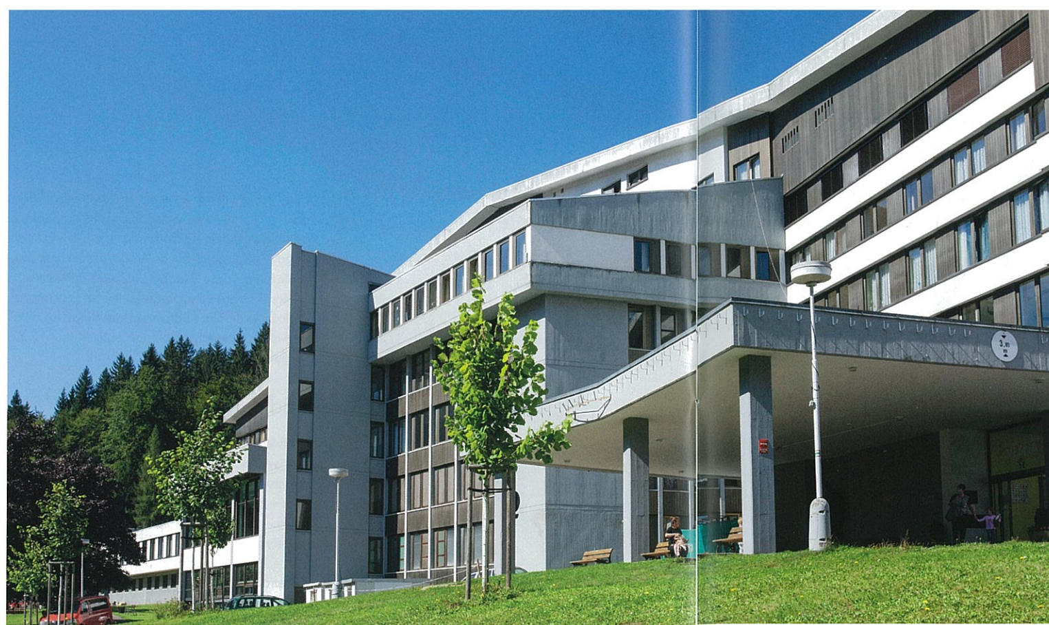
> Rekonstrukce dětské léčebny probíhá za plného provozu
