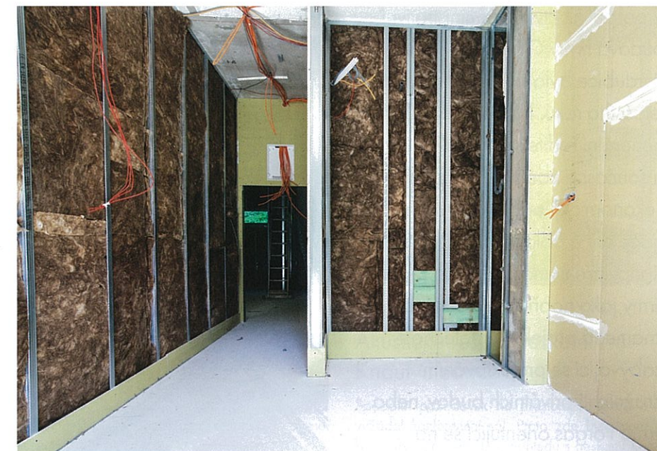
> Všechny příčky jsou dvojité opláštěné deskou TOPAS
